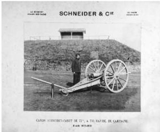
Um dos primeiros modelos de peça de campanha 75 mm Tiro Rápido Schneider-Canet, modelo. 1895-98 com ligação elástica integralmente hidropneumática, em fotografia publicitária do fabricante.
