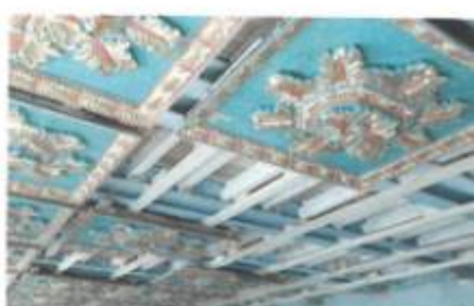
À esquerda: Caixotão em fase de intervenção, através de limpeza química das camadas de douramento e de policromia; ao centro: Construção da estrutura de suporte para remontagem do teto; à direita: Montagem dos caixotões.
