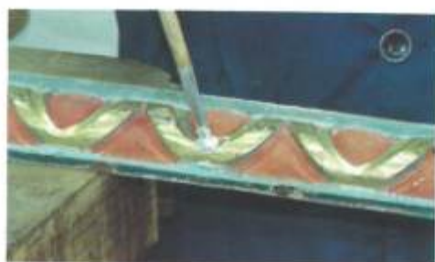
Detalhes da intervenção no suporte de madeira: extração de prego, seguida de limpeza da área de madeira manchada com óxidos de ferro (à esquerda); Aplicação de adesivo (ao centro); Colocação de bucha de madeira (à direita).
