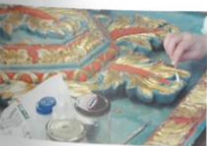
À esquerda: Caixotão em fase de intervenção, através de limpeza química das camadas de douramento e de policromia; ao centro: Construção da estrutura de suporte para remontagem do teto; à direita: Montagem dos caixotões.
