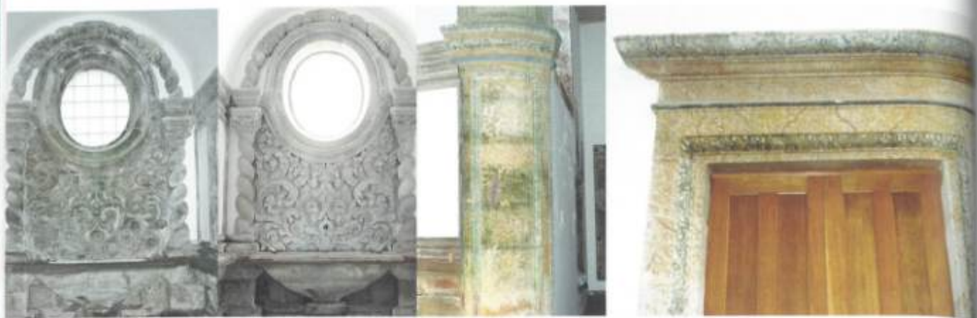
Nas duas fotos à esquerda: Lavabo esculpido antes da intervenção, com extensa colonização por algas e fungos, e após a desinfecção e limpeza química (Fotos: Paulo Lobão [DRC] MAH). Nas duas fotos à direita: Pintura decorativa aplicada nos elementos arquitetónicos em pedra, no caso, numa piastra do intradorso antes da intervenção e nas ombreiras e lintel de porta, após a intervenção (Fotos: Manuela Neves e Marta Inácio [DRC] DSP [DPMIA]).
