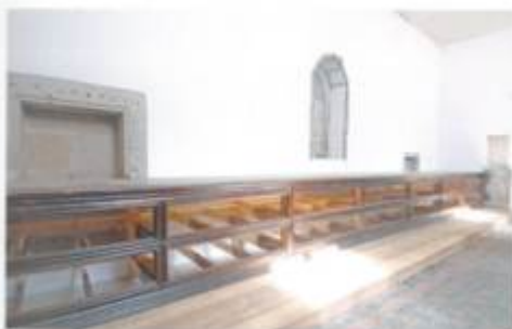
À esquerda: Execução de elementos de madeira em falta e aplicação de camada de preparação nas áreas novas e nas lacunas; à direita: Após douramento das áreas novas e das lacunas.
