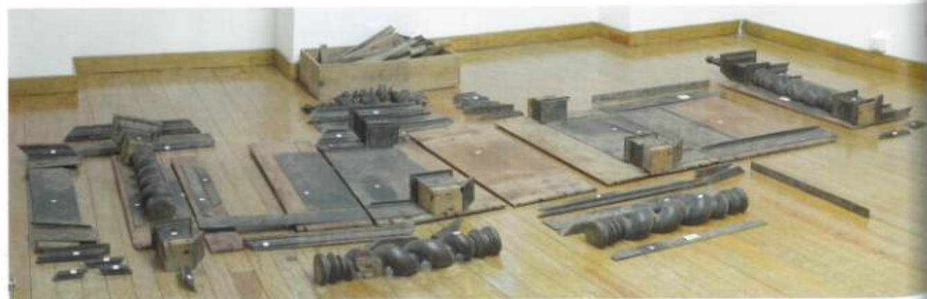
Elementos do esquadro que integra painéis em pintura, localizado na parede oposta ao arco, antes da intervenção, com as várias componentes desmontadas com as respetivas etiquetas de marcação.
