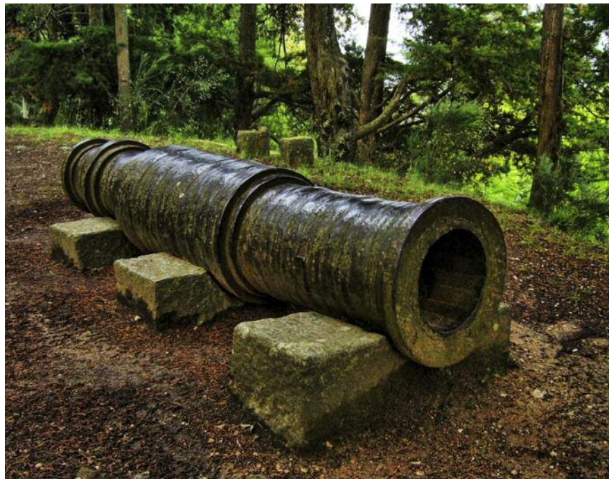
Outra bombard de Pinhel, em ferro forjado, do século XV. Construída também pela justaposição de barras de ferro longitudinais, reforçadas por argolas de ferro transversais colocadas contiguamente e reforçadas em algumas partes, com outros conjuntos de argolas mais exteriores. Parque da Trincheira, Pinhel
